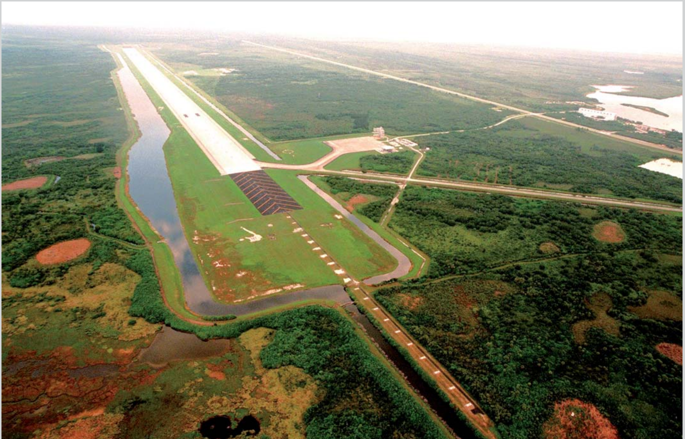
Die Launch and Landing Facility (LLF) von Space Florida am Kennedy Space Center ist eine 4,5 km lange und 100 m breite Start- und Landebahn, die als amerikanisches Gegenstück einer Logistikbrücke zum European Hub in Dübendorf dienen wird.
